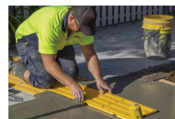
3. วางกระเบื้องลงบนคอนกรีตที่เปียกเบาๆ ในขณะที่คอนกรีตยังอ่อนอยู่ ลงในตำแหน่งที่กำหนดไว้
