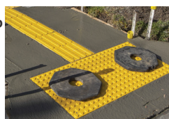
5. ใช้น้ำหนักตัววางกระเบื้องให้อยู่กับที่ ควรวางน้ำหนักกับบนกระเบื้องเพื่อยึดให้อยู่กับที่จนกว่าคอนกรีตจะเซตตัว
