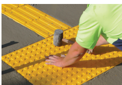
4. ใช้ค้อนยางเคาะกระเบื้องลงบนคอนกรีตจนกว่ากระเบื้องจะเรียบเสมอกับคอนกรีตโดยรอบ
