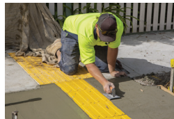
6. ตบแต่งขอบกระเบื้องให้เรียบรอยเสมอกัน เมื่อคอนกรีตแห้งแล้ว ยกตัวน้ำหนักออกแล้วทำความสะอาดให้เรียบเรียบร้อย
