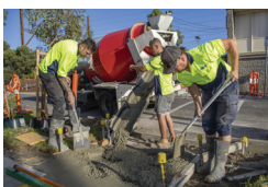
1. เทคอนกรีตเตรียมพื้นที่ติดตั้ง
